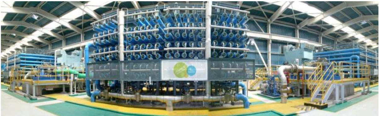
Figura 2 – Planta Industrial Dessalinizadora Por Osmose Reversa
