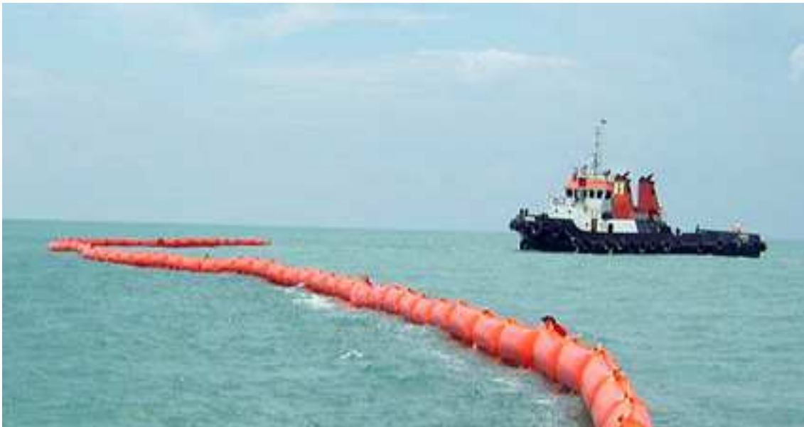
Figura 21 – Lançamento da barreira
