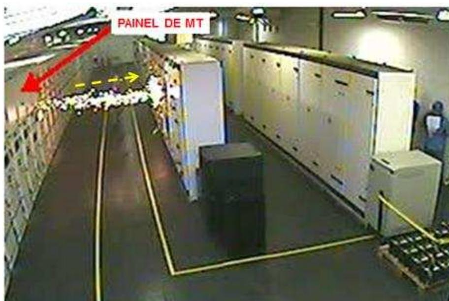
Figura 11 – Câmera da subestação mostrando o instante da ocorrência do arco
