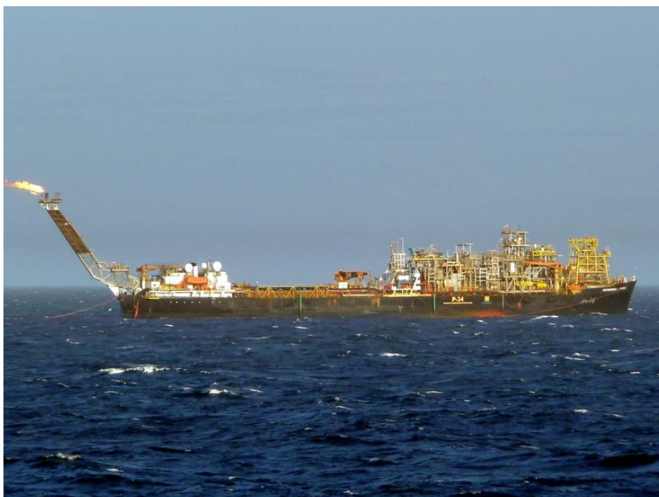
Figura 8 – FPSO PP Moraes.
