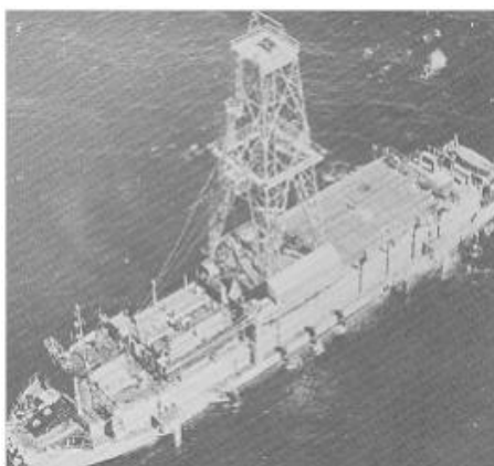
Figura 14 - CUSS 1, o primeiro navio a ser dinamicamente posicionado, consequênciado projeto Mohole (1961)
