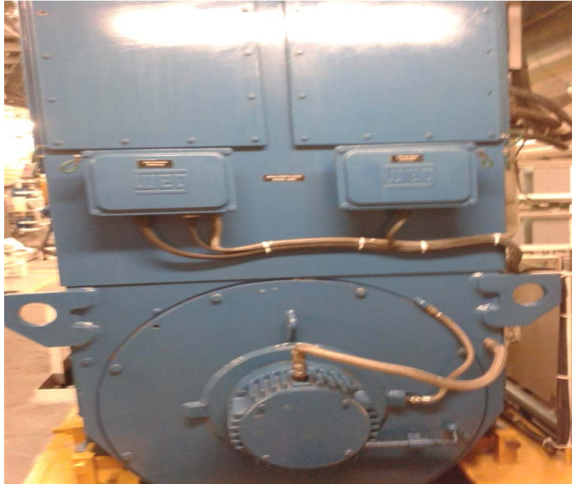
Figura 35 - Vista frontal do gerador
