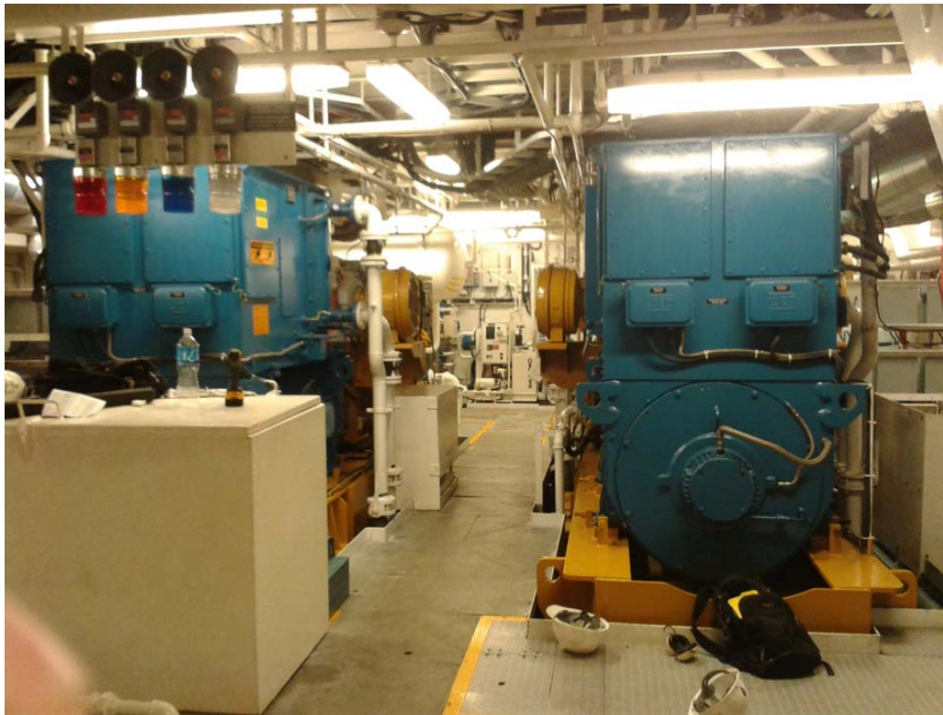
Figura 34 - Geradores na praça de máquinas
