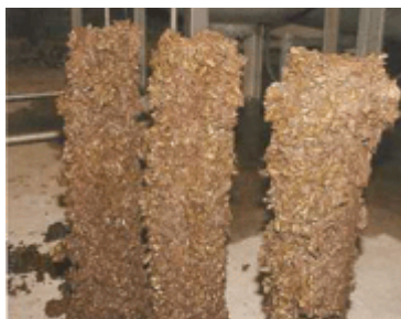
Figura 3: Filtros obstruídos pelo molusco. Fonte: (FURNAS, 2011)
