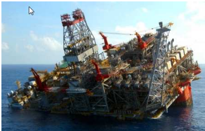
Figura 6: Perda de Estabilidade
