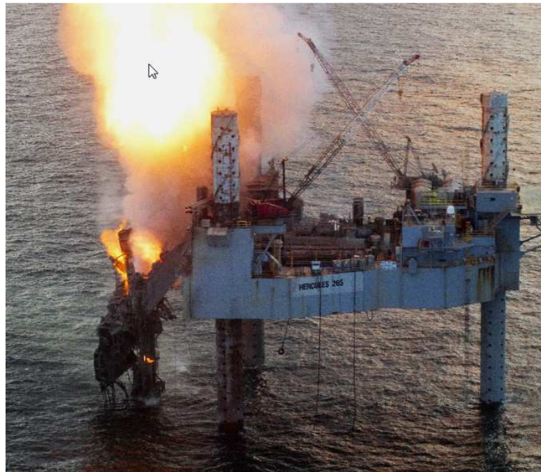
Figura 5: Controle de Poço mal sucedido
