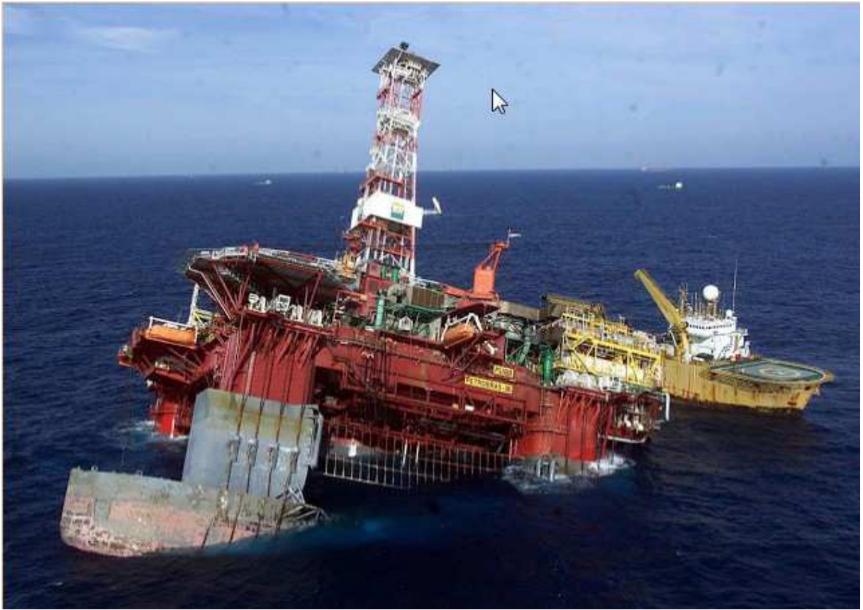
Figura 11: Petrobras 36 com estabilidade comprometida
