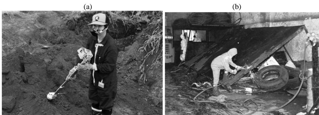
Figura 4 – Monitoração do solo e demolição do ferro-velho onde vazou o Césio 137
