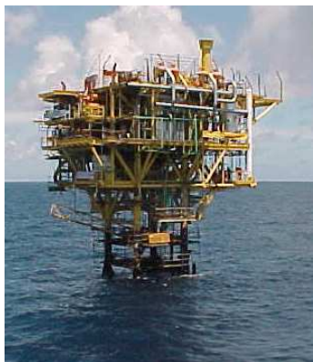
Figura 30: Plataforma Jaqueta elevatória. Fonte: (próprio autor)
