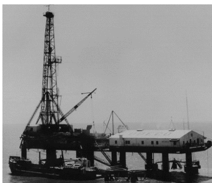
Figura 32: Plataforma de perfuração tipo submersível. Fonte: (BlogMercante)
