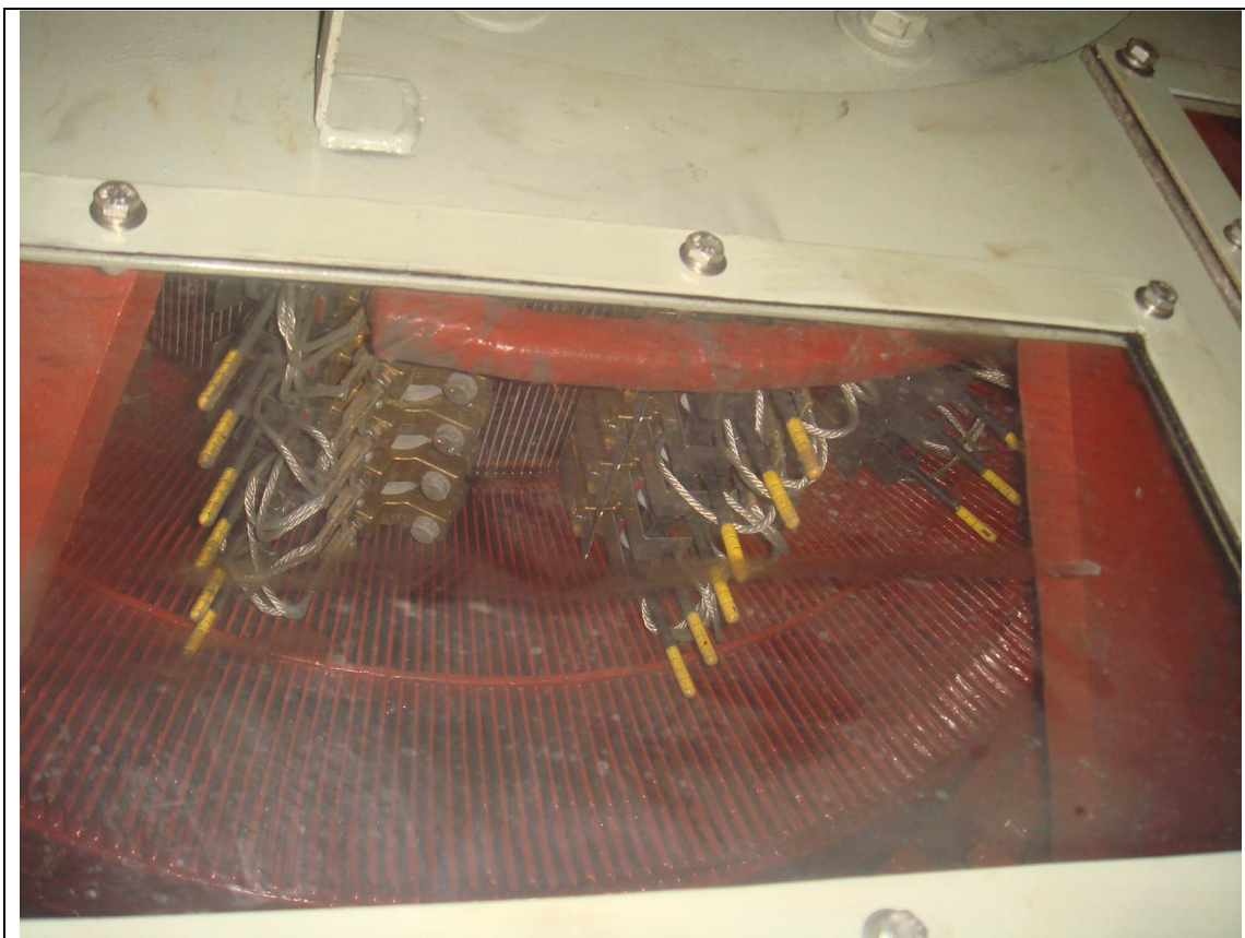
Figura 11: Janela de Inspeção do Motor de Propulsão do Rebocador: Richard M. Currence, com visão das escovas.
