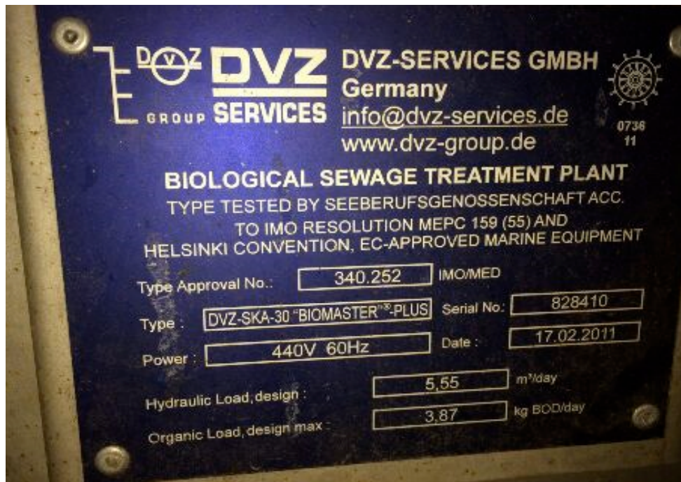
Figura 2 – Placa de identificação de uma unidade de tratamento
