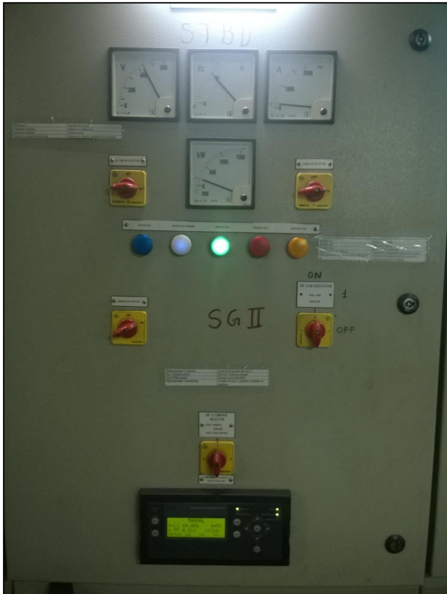
Quadro elétrico do gerador de eixo de boreste
