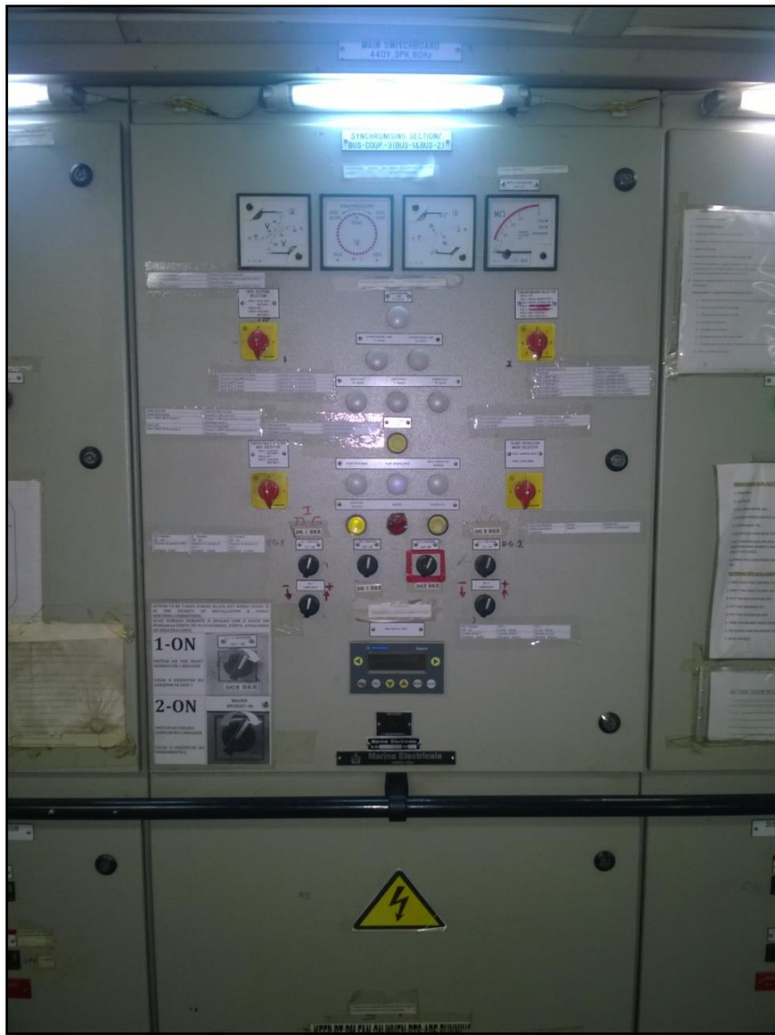
Quadro elétrico completo do sistema de barramento
