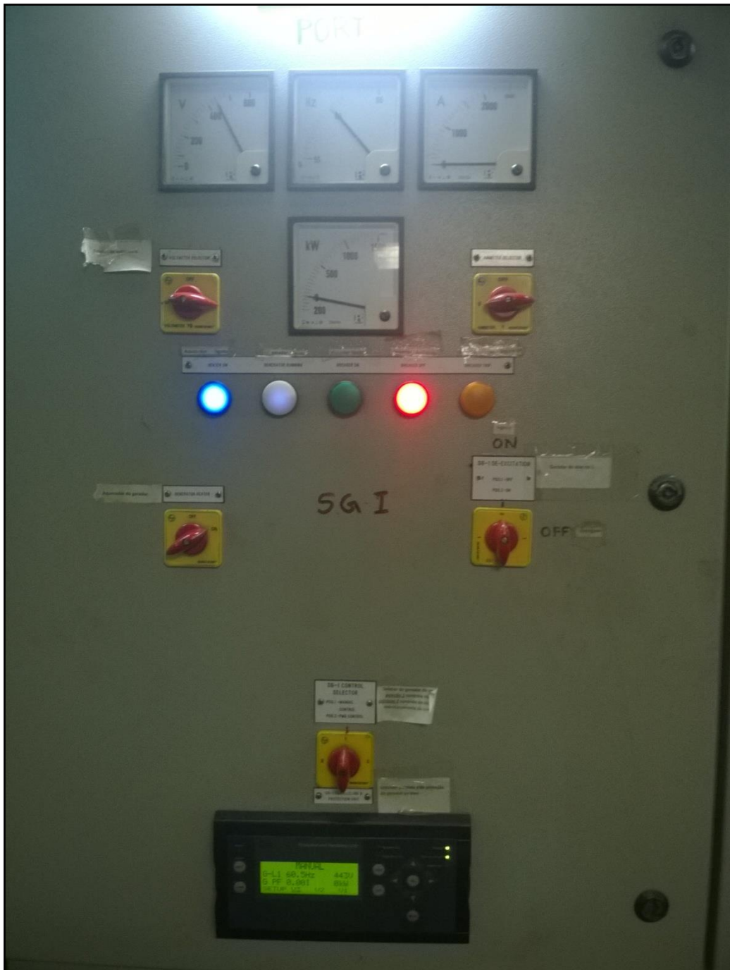
Quadro elétrico do gerador de eixo de bombordo
