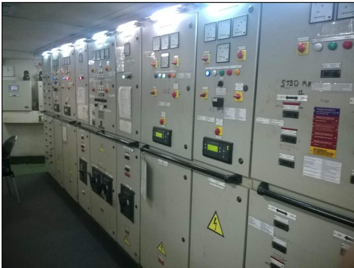
Vista geral do quadro de alimentação da embarcação TAG 5
