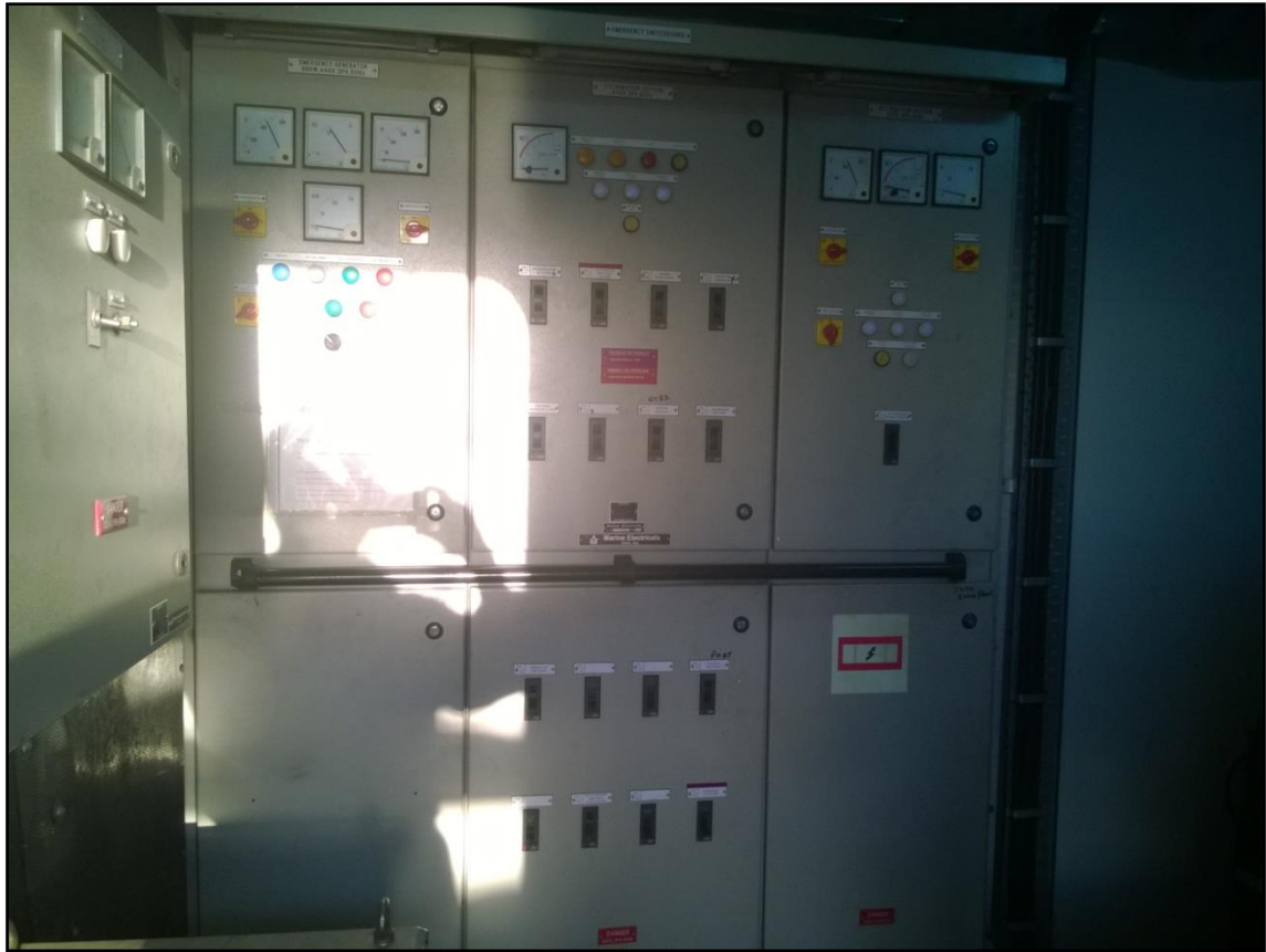
Quadro elétrico do gerador de emergência
