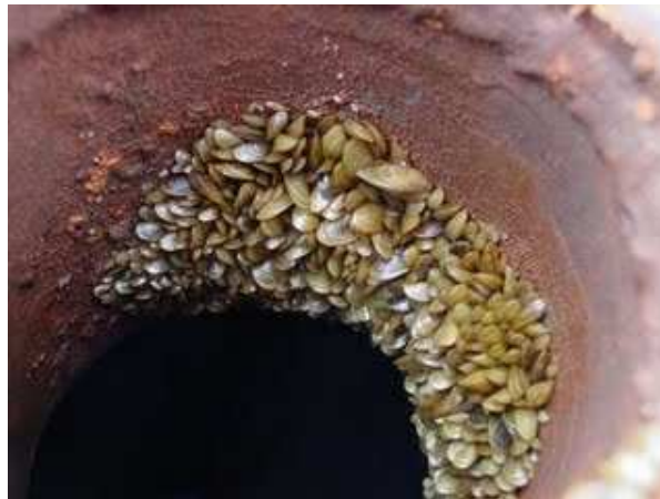
Figura 3 - Mexilhões alojados em tubulações
