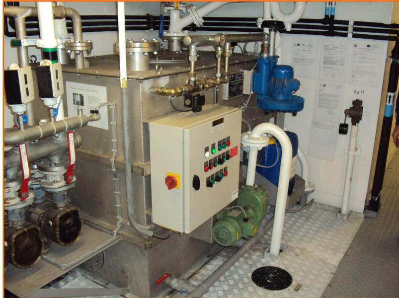
**Figura 03:** Sistema de tratamento de efluentes
