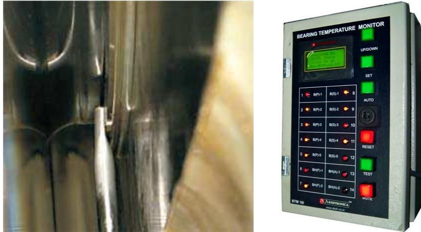
Figura 23 - Monitoramento da temperatura dos mancais do motor
