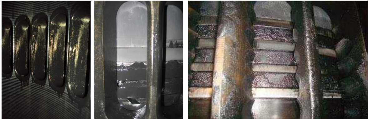
Figura 2.8- Acúmulo de óleo e incrustações formadas pelo excesso de óleo lubrificante Fonte: Maritime University of Szczecin Poland
