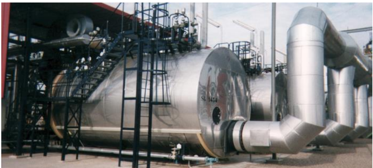
Figura 2.7- Caldeira de Geração de Vapor de Processo Industrial Fonte: Planta Industrial
