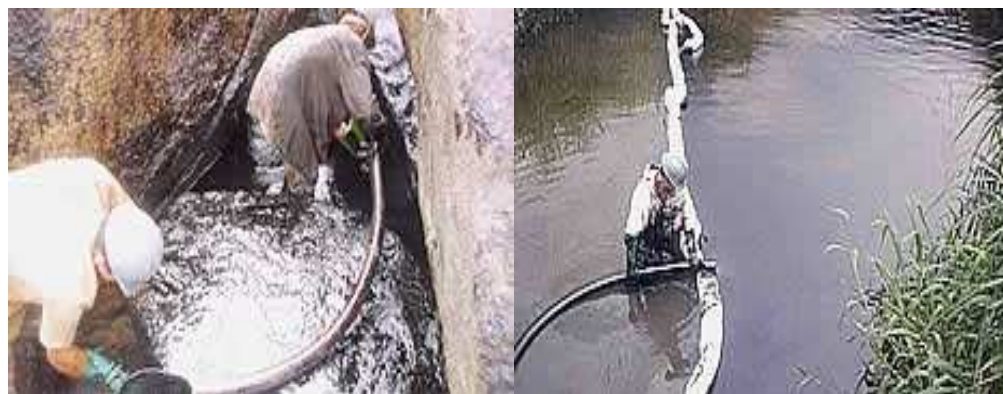
Figura 9 – Bombas a vácuo.
