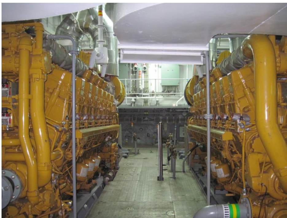
FIGURA 9 – Motores de Combustão Principais (MCP) Caterpillar, modelo C280-16
