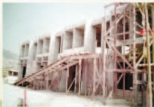
Detalhe da obra da fachada do hotel em agosto de 1976.
