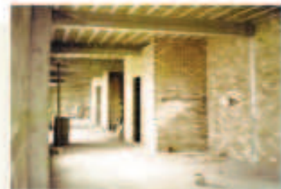
Corredor dos alojamentos – agosto de 1976.
