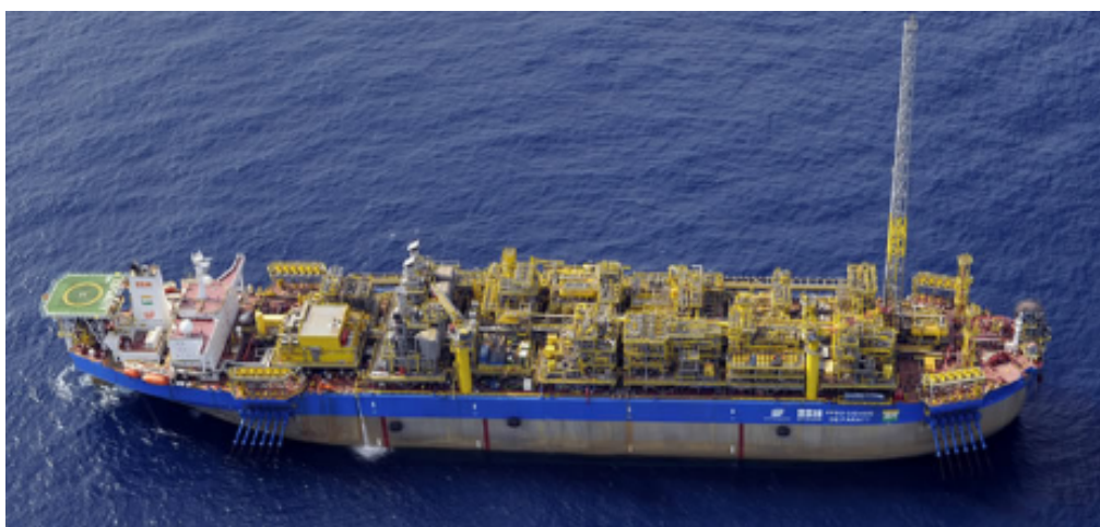
Figura 18: Plataforma FPSO P-63.
