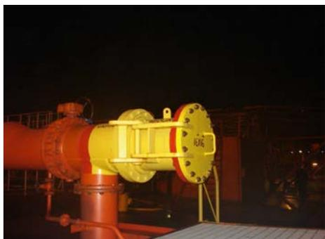
Figura 15: Tomada para conexão da rede retorno de vapores do Terminal.
