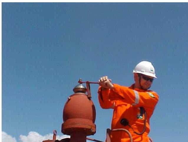
Figura 16: manutenção em uma válvula PV pela tripulação.
