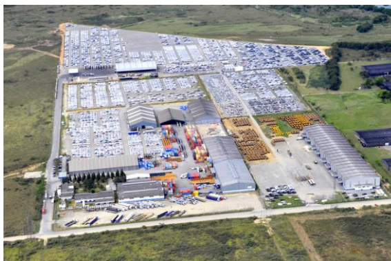
Foto 5 - Porto seco de Resende – RJ
