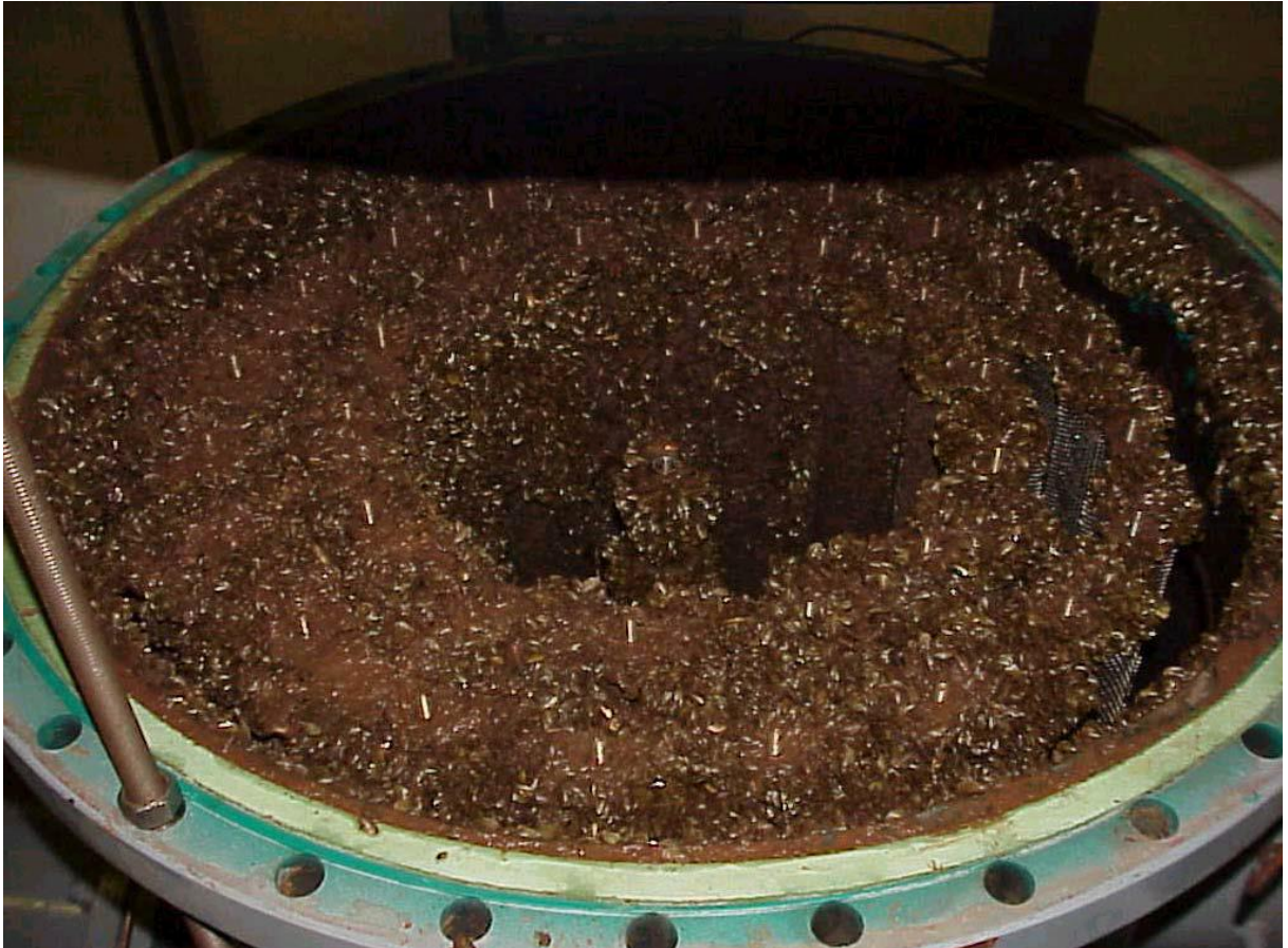
Figura 9: Mexilhão dourado em sistema da Usina de Itaipu
