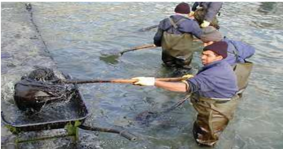
Figura 36 – Remoção manual do óleo Fonte: ITOPF, 2012g.
