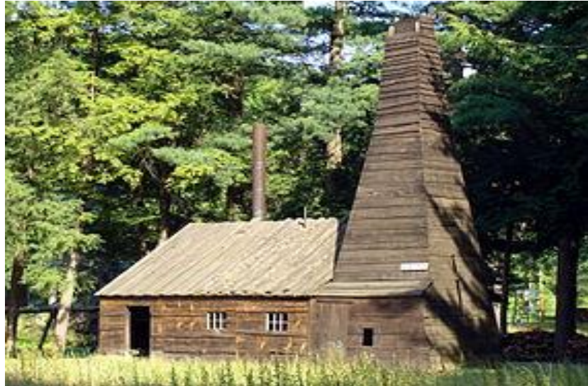
Figura 1 – Foto do primeiro poço Americano perfurado pelo coronel Edwin Drake no estado da Pensilvânia no ano de 1859
