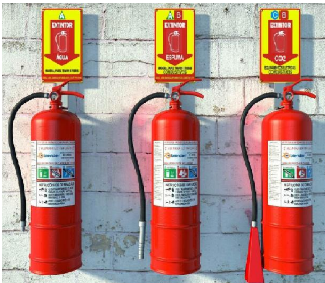
Figura 5 : Extintores de incêndio
