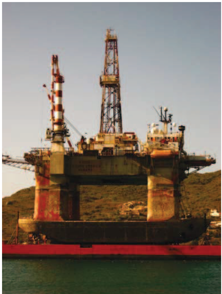
Figura 1 - Foto de uma plataforma rebocada para o porto do Forno em Arraial do Cabo para manutenção e troca de estruturas.
